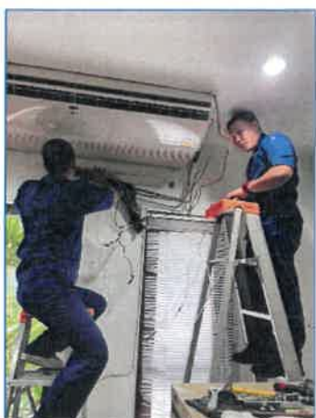
ภาพถ่ายที่ 2.2-11 การทำความสะอาดเครื่องปรับอากาศ
