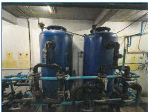
ภาพถ่ายที่ 2.2-13 หัวรับน้ำสำรอง ระบบปรับปรุงคุณภาพน้ำ และถังสำรองน้ำใช้
