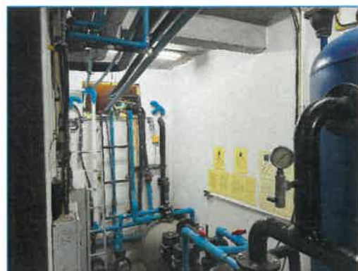
ภาพถ่ายหัวรับน้ำสำรอง ระบบปรับปรุงคุณภาพน้ำ และถังสำรองน้ำใช้
