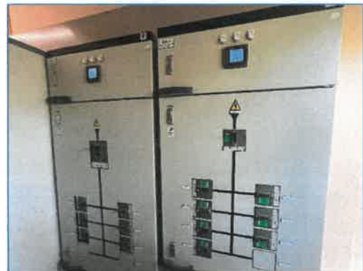
ภาพถ่ายที่ 2.2-7 หม้อแปลงไฟฟ้าและตู้ MDB ควบคุมระบบไฟฟ้า
