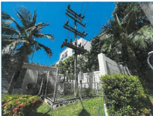
ภาพถ่ายที่ 2.2-7 หม้อแปลงไฟฟ้าและตู้ MDB ควบคุมระบบไฟฟ้า
