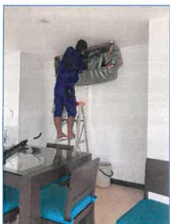
ภาพถ่ายที่ 2.2-11 การทำความสะอาดเครื่องปรับอากาศ
